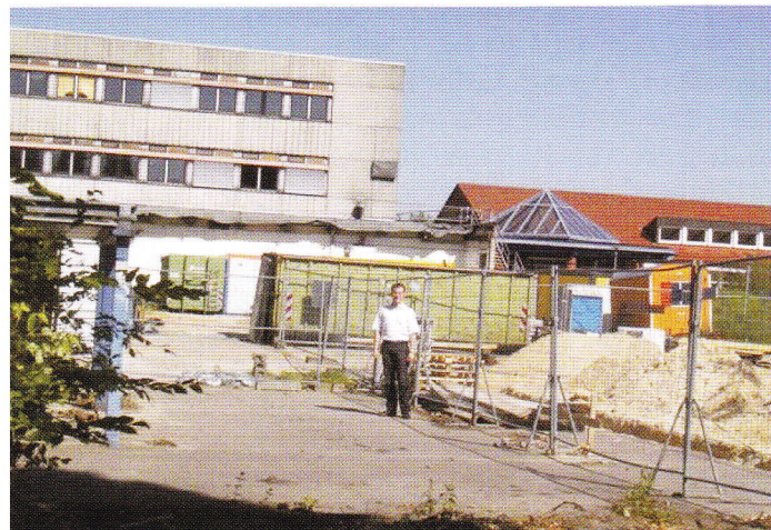
Bild: Baustelle GFS - Von der Teilsanierung zum Komplettneubau?
